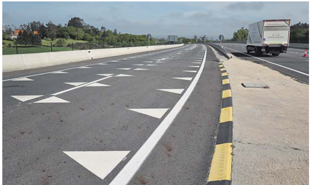
DIENTES DE DRAGÓN EN SANTIAGO. La imagen muestra las marcas viales pintadas en tramos previos a dos rotondas de la autovía SC-30 (enlace orbital de Santiago). Se conocen como dientes de dragón y provocan sensación de estrechamiento de la calzada. X. A. SOLER
